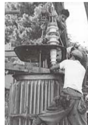
1959(昭和34年)高田変電所点検
