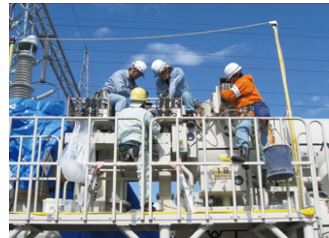
2011年(平成23年)発変電現場
