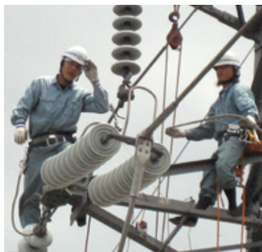
2008年(平成20年)送電現場
