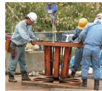
2009年(平成21年)送電現場
