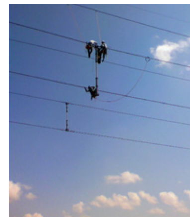
2014年(平成26年)送電現場
