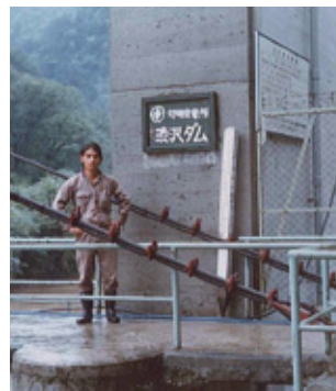
1975(昭和50年)東電切明発電所
