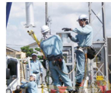
2010年(平成22年)発変電現場
